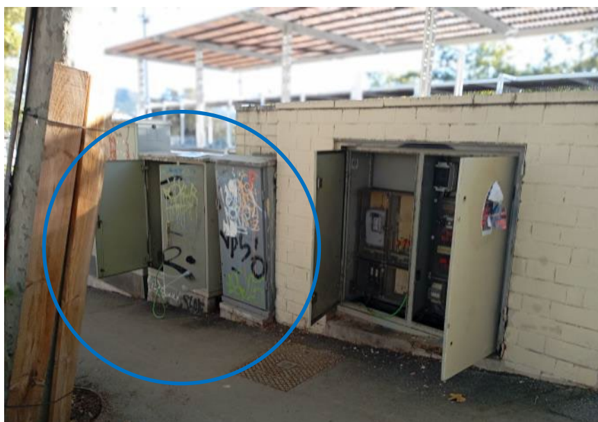
Imatge 5 Armaris d'electricitat existents (esquerra previsió antiga guingueta, dreta enllumenat públic)
